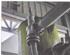
รูปมาตรฐานวัดแรงดันหลังออกจากอุปกรณ์ปรับลดแรงดัน
