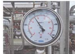
รูปมาตรฐานแรงดันหลังออกจากอุปกรณ์ปรับลดแรงดัน
